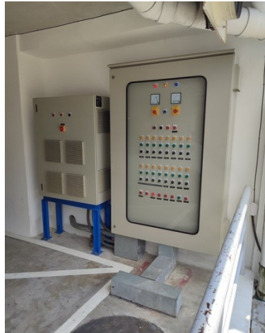
ภาพที่ 5-9 ตู้ควบคุมระบบบำบัดน้ำเสียและมิเตอร์แยกเฉพาะระบบบำบัดน้ำเสีย
