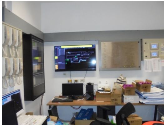
ภาพที่ 5-21 แผงควบคุมการรับส่งสัญญาณตรวจรับอุปกรณ์แจ้งเหตุเพลิงไหม้
