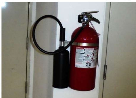
ภาพที่ 5-19 ถังดับเพลิงมือถือชนิดคาร์บอนไดออกไซด์
