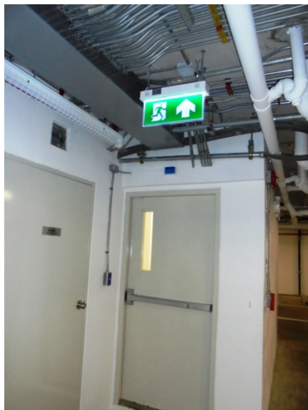
ภาพที่ 5-26 ป้ายบอกทางหนีไฟและป้ายบอกชั้นอาคาร
