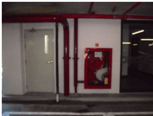
ภาพที่ 5-18 ท่อในระบบน้ำดับเพลิง และตู้เก็บสายฉีดน้ำดับเพลิงพร้อมอุปกรณ์
