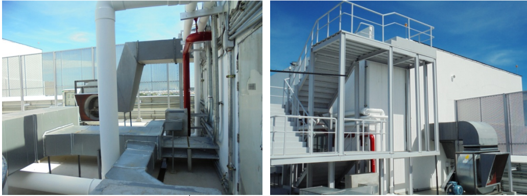
ภาพที่ 5-27 พัดลมอัดอากาศใช้กับบันไดหนีไฟ
